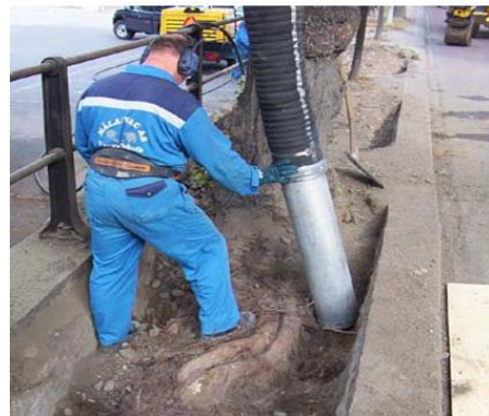
Figur 44: Bildet viser fjerning av gamle vekstmasser med vakuumsuger, for klargjøring for tilbakefylling av rotvennlig forsterkningslag. (Foto: Ørjan Stål, Sweco, VBB og Bjørn Embrén, Stockholm Stad)
