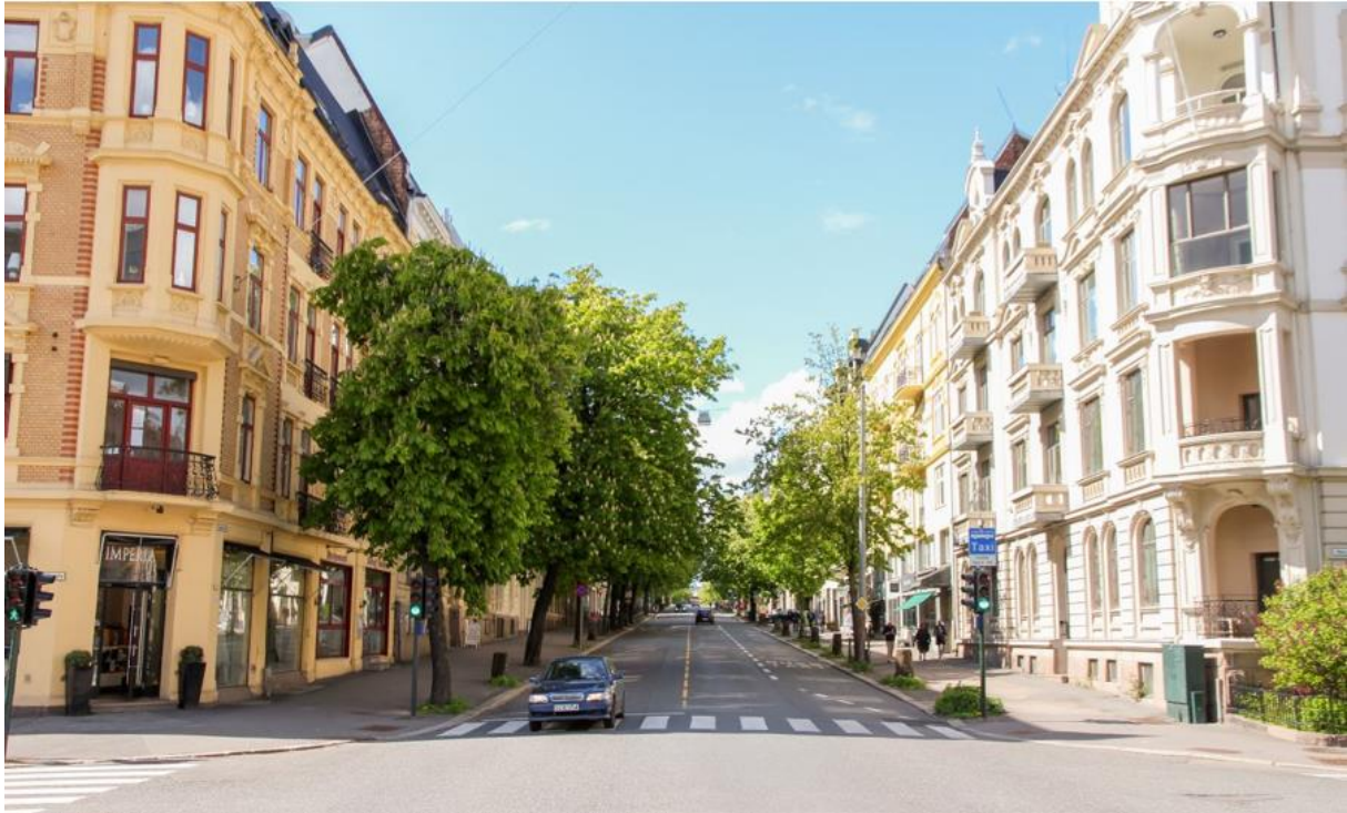
Figur 9: Bygdøy allé ved Niels Juels gate (Kilde: Norconsult AS, Anders Hartmann).
