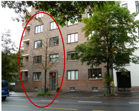
Figur 4: Illustrerer at også yngre trær lider under dårlige forhold. Treet markert ble plantet i 1999 og har mistet alle blader allerede i august (Bilde fra tilstandsvurdering, 2010).
